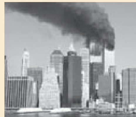
Las torres gemelas del World Trade Center, heridas, antes de la secuencia del colapso final.
